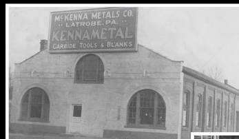
Originalgebäude der McKenna Metals Company in Latrobe, Pennsylvania, Ende der 1930er/Anfang der 1940er Jahre.
